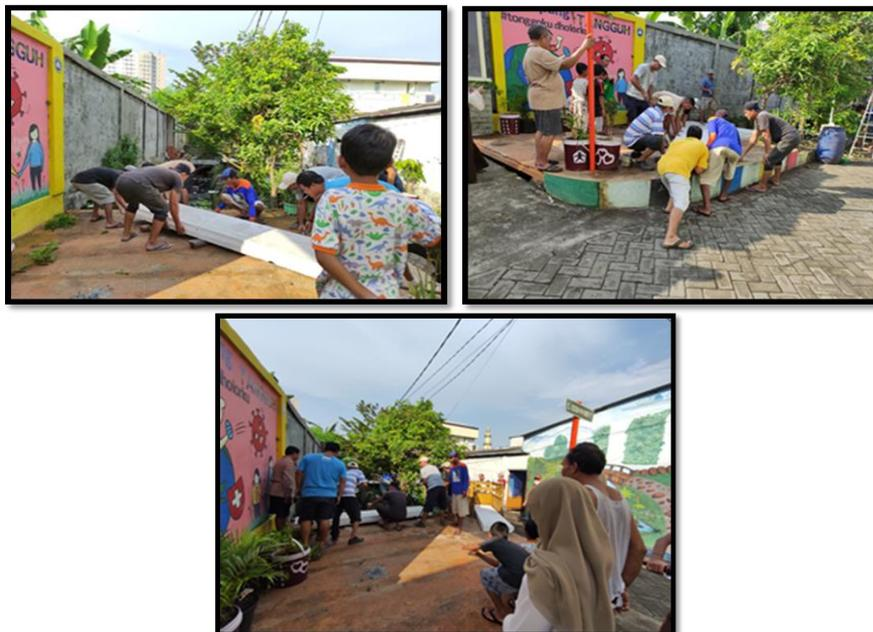
Gambar 5. Pemasangan panel lantai di atas saluran drainase
