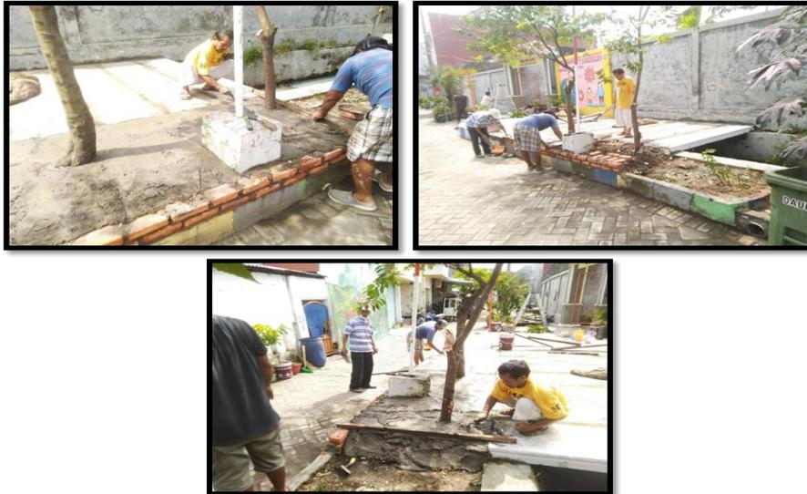
Gambar 6. Pemasangan batu bata dan pembuatan Lantai
