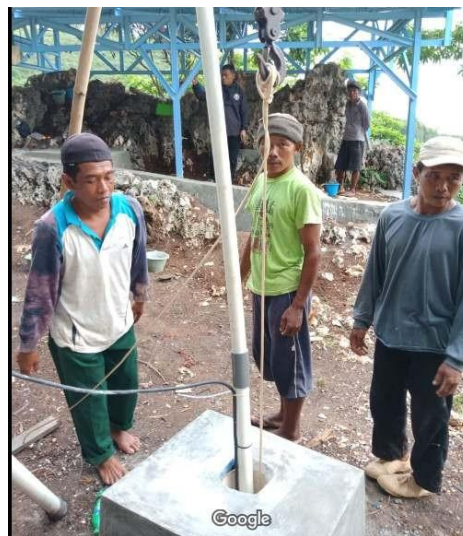
Gambar 9 Pemasangan Pompa Air Sumber: Dokumentasi Tim
