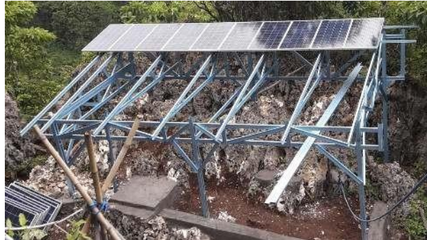
Gambar 8 Pemasangan Panel Surya Sumber: Dokumentasi Tim
