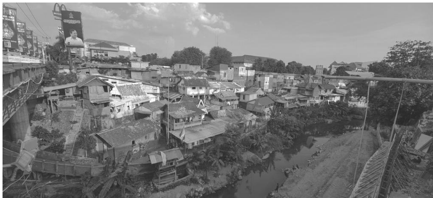
Foto 6. Bangunan lama yang dipotret dari samping Jembatan Gondolayu
