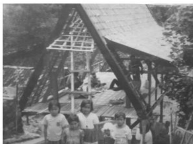
(b) Paseban yang hampir selesai dibangun
