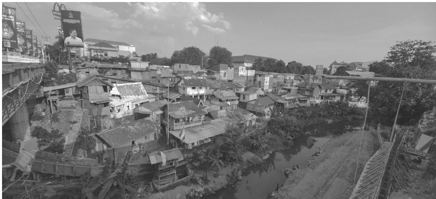
Foto 8. Bangunan lama yang direnovasi dipotret dari atas Jembatan Gondolayu
