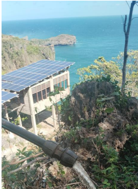
Gambar 6. Air keluar dari sumur bor setelah sistem panel surya dihidupkan.
