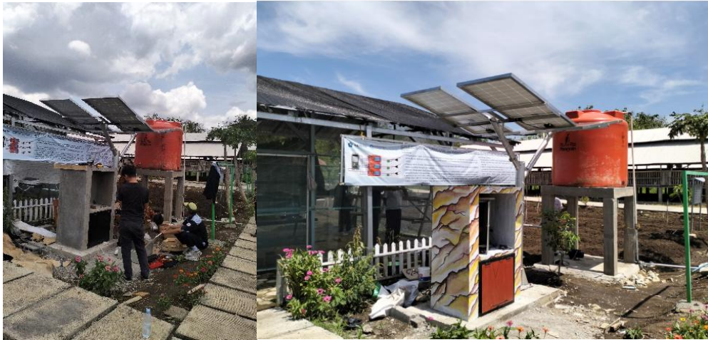
Gambar 4. Pemasangan Instalasi PLTS untuk Mendukung Operasional Pompa Air pada Sistem Sprinkler
