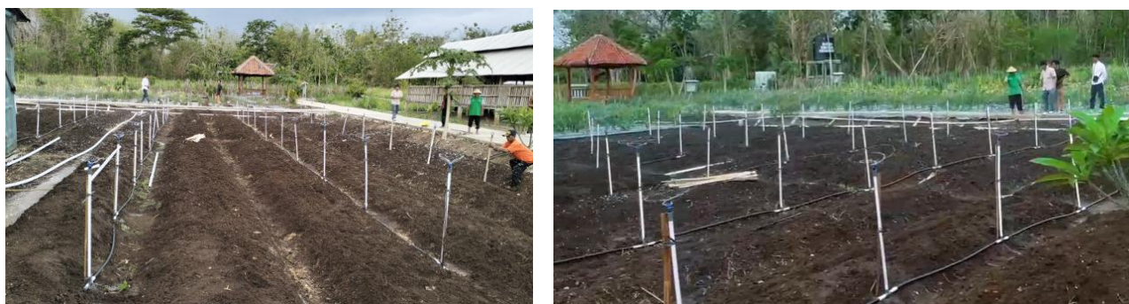
Gambar 5. Hasil Akhir Pemasangan Sistem Sprinkler di Lahan Pertanian.
