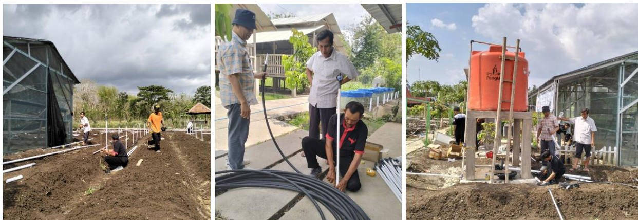
Gambar 5. Tim Pelaksana dan Mitra Melakukan Pembuatan serta Pemasangan Perangkat Sprinkler, termasuk Tandon, Pipa, dan Pompa Air
