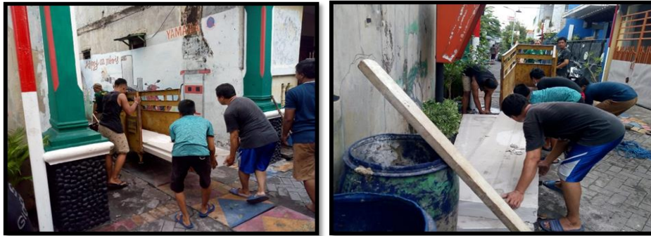
Gambar 4. Pemindahan panel lantai ke lokasi
