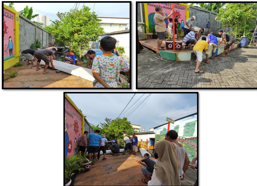
Gambar 5. Pemasangan panel lantai di atas saluran drainase
