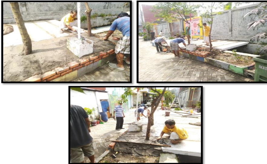
Gambar 6. Pemasangan batu bata dan pembuatan Lantai
