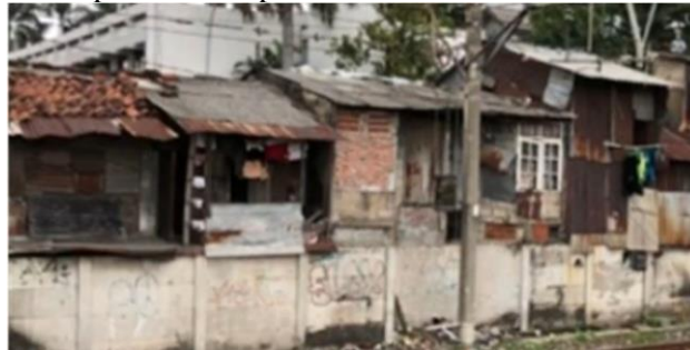
Gambar 1. Kondisi pemukiman Jatipulo
