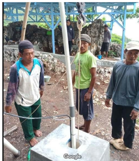
Gambar 9 Pemasangan Pompa Air Sumber: Dokumentasi Tim
