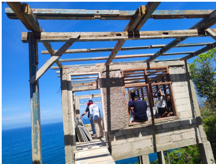
Gambar 3. Pembuatan Konstruksi Atap untuk Penempatan Panel Surya
